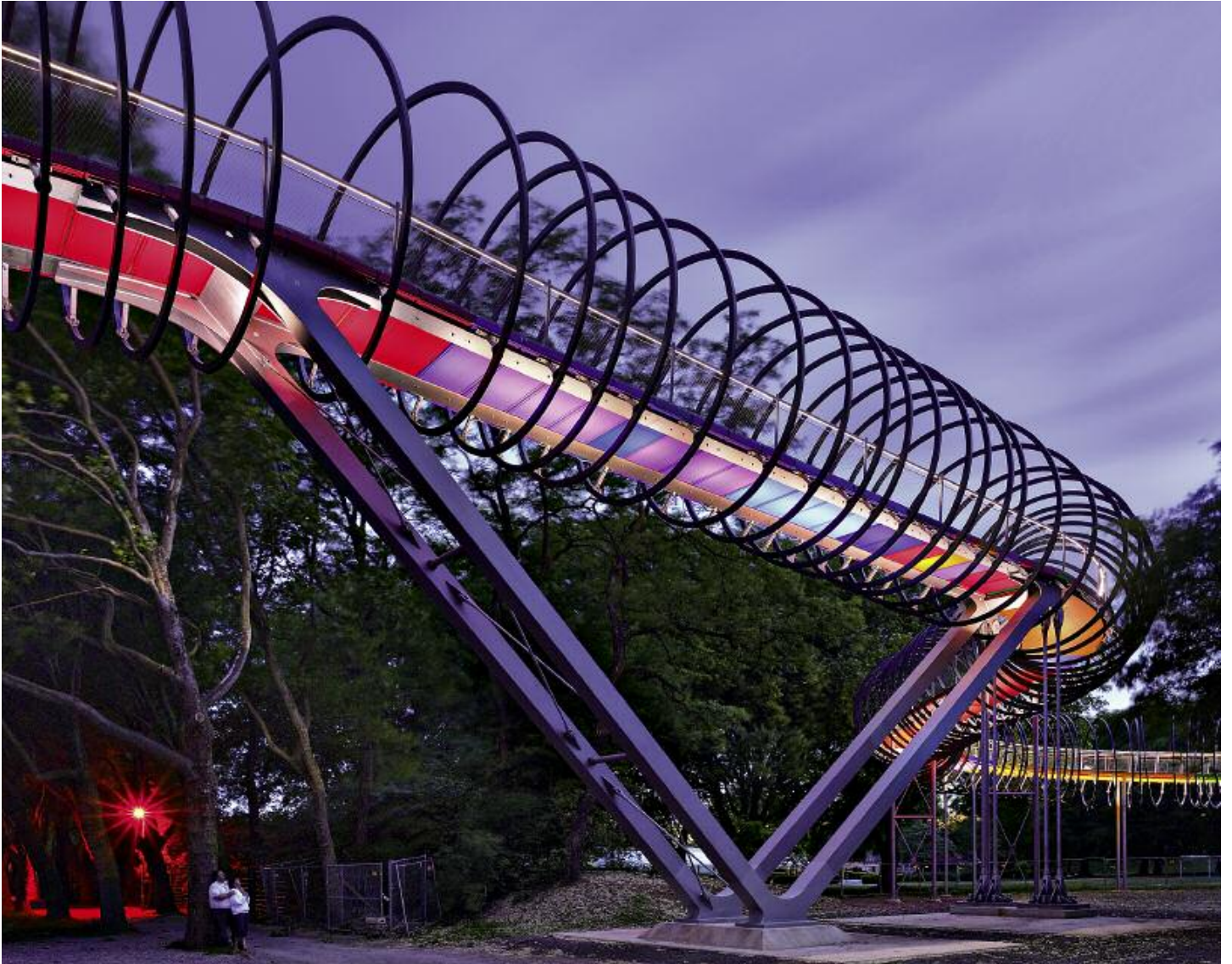
Die V-Form der vom Ufer zurückversetzten Stützen reduziert die Spannweite des Hauptfeldes über dem Kanal.
