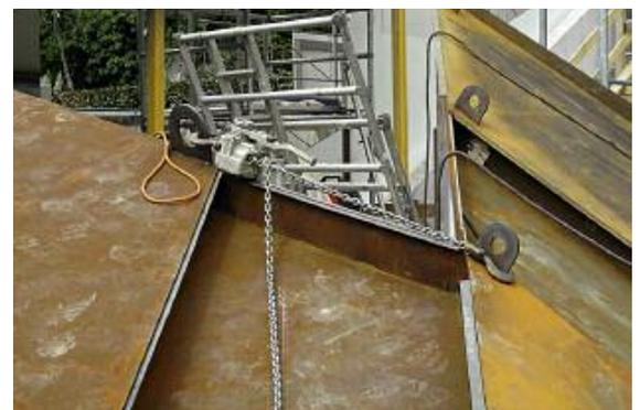
Le montage de la construction métallique, en partie préfabriquée, s'est fait d'aval en amont. Une fois mis en place et fixés aux consoles, les éléments en acier ont été soudés entre eux.
