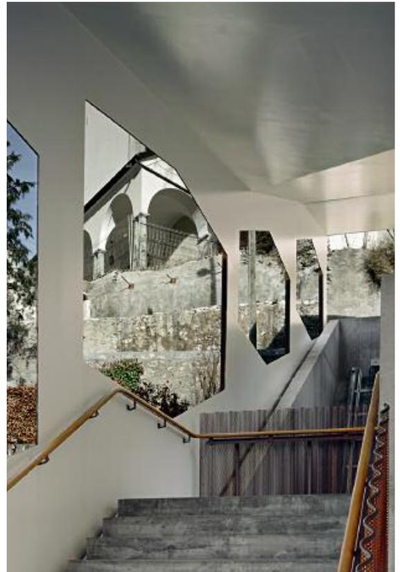
Die seitlichen Wandelemente setzen sich aus je vier Stahlblechen zusammen und bilden so den Rahmen für die wabenförmige, sechseckige Öffnung. Die aneinander gereihten Elemente sind mit vertikalen Rippen als äussere Stützen verstärkt. Damit erhält die flache Konstruktion auch eine räumliche Dimension.
