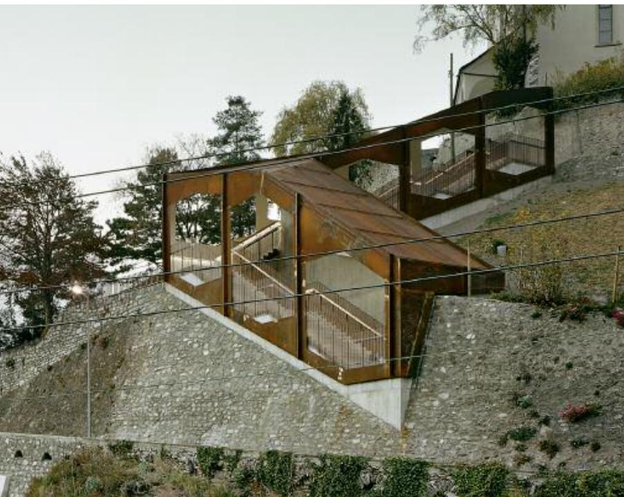
Die leichte, aufgesetzte Struktur aus wetterfestem Stahl ist in das Relief des Hangs und der Stützmauern eingebettet.
