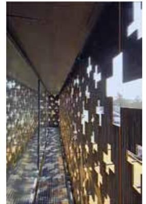
Das komplexe, unregelmässige Muster verlangte in der Umsetzung absolute Präzisionsarbeit. Jede Stahlplatte ist ein Unikat.
