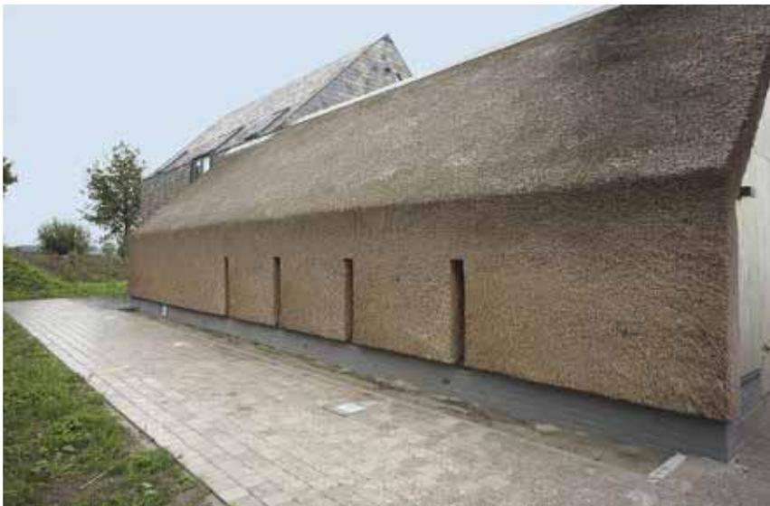
bäude. Mit dieser ununterbrochenen homogenen Hülle, betonen die Architekten die abstrakte Form. So wird die Silhouette der beiden Volumina auch nicht von einer Dachrinne unterbrochen, nur über den Fenstern und Türen wird das Wasser von kleinen Rinnen aufgefangen und weggeleitet.
