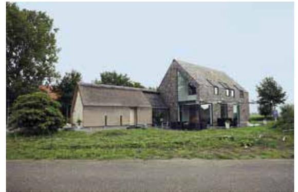
Das heisst, die Ausfachung zwischen dem Stahlskelett besteht aus Holzrahmen die mit Holzfaserdämmplatten ausgefüllt sind. Eine durchgehende Schicht solcher Dämmplatten umhüllt die Stahlkonstruktion zusätzlich auf der Aussenseite. Erst dann folgt die vorgehängte, hinterlüftete Wetterschutzhülle aus Schiefer.
