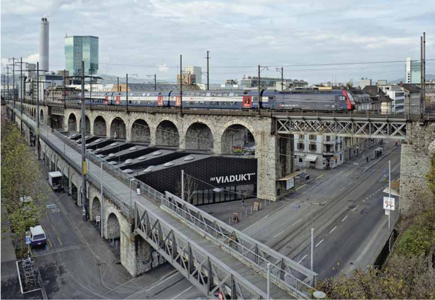
Entre les viaducs de Wipkingen et du Letten se trouve le premier marché couvert de Zurich.
