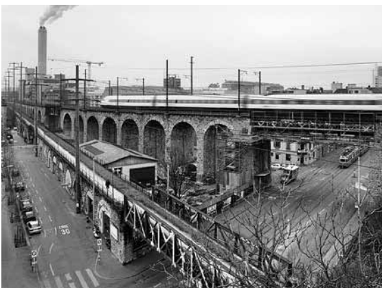
Le viaduc avant sa réaffectation.
