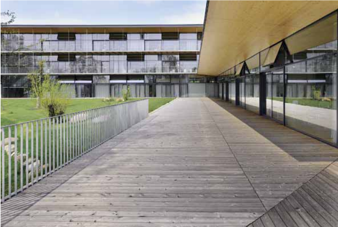
Blick auf die südseitigen Klassenzimmer der Oberstufe, im Vordergrund der grosszügige Aussenraum zu den Primarschulzimmern.
