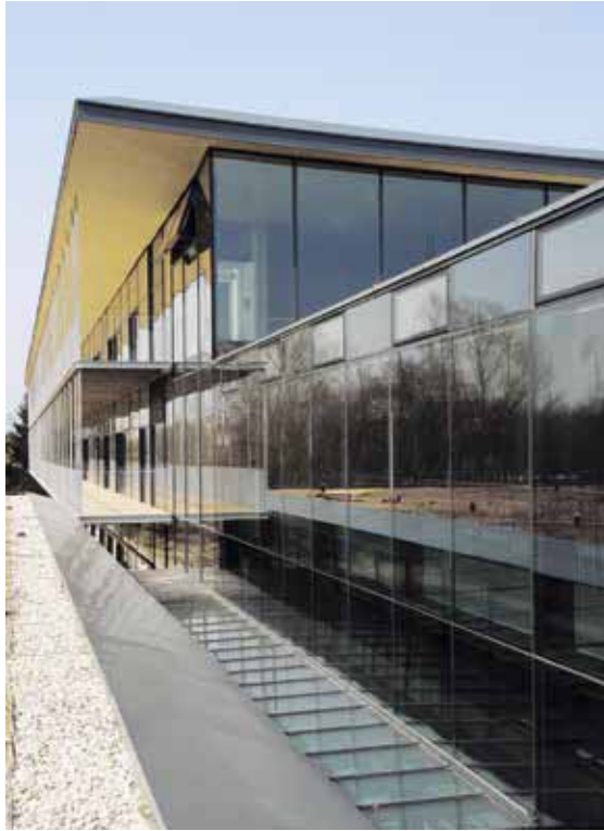
Blick auf das Oblichtband über der Garderobe der Primarschule. Klassenzimmer der Oberstufe im Hintergrund.
