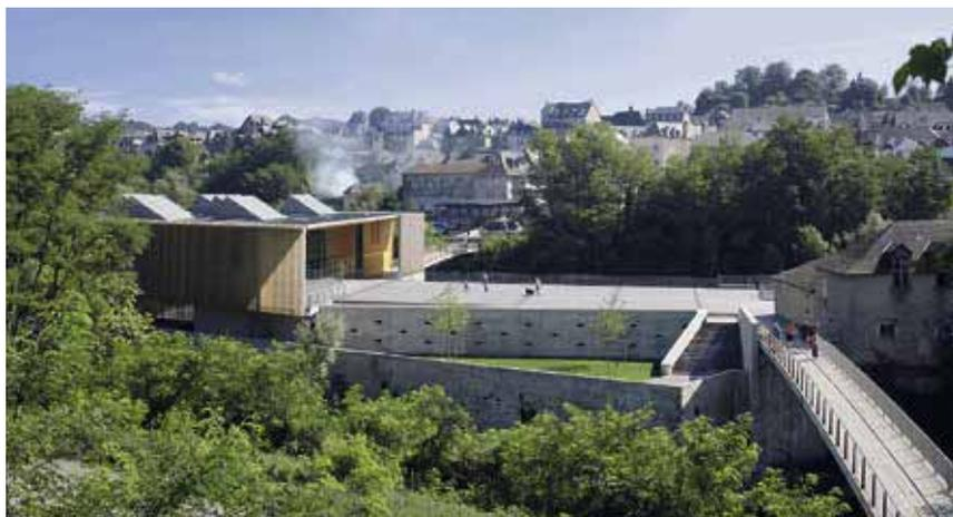
Fichée sur un socle de verre, la construction est lancée en porte-à-faux au-dessus du balladoir, sorte de galet en lévitation. Elle affirme sa tranquille présence à l'abri d'une peau de bois à claire-voie réalisée en lamellé-collé de douglas.
