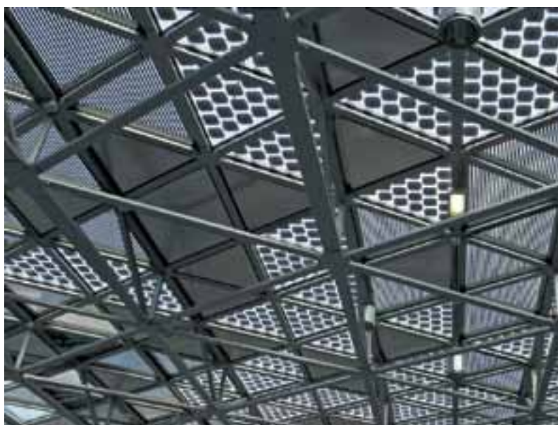
Vue intérieure de la toiture
