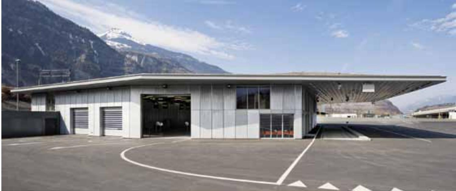
Une halle pour grands véhicules aux dimensions impressionnantes: le porte-à-faux de l'avant-toit est de plus de 13 mètres.
