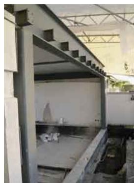
Durant les travaux, un couvert a été installé pour protéger le chantier. Le montage de la charpente métallique préfabriquée s'est fait en quelques jours.
