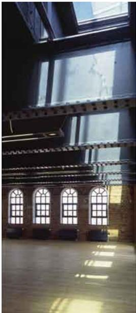
Depuis la salle d'aérobic, on peut presque toucher le fond du réservoir, qui repose sur les poutres rivetées.
