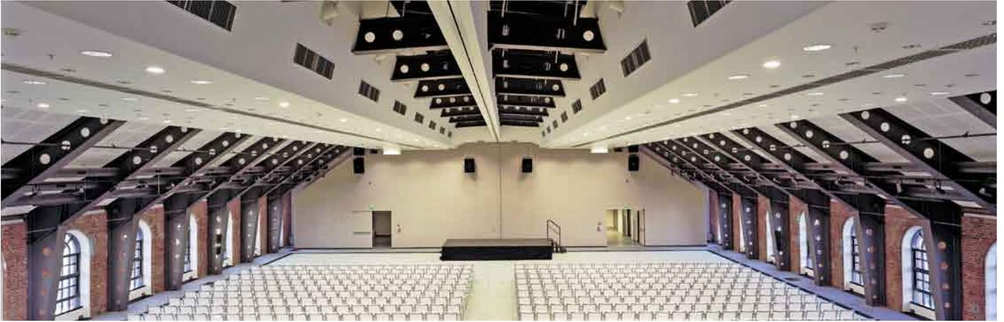
Pour créer une salle de bal au quatrième étage du bâtiment historique les poteaux en fonte de l'ancienne halle des machines ont été enlevés et remplacés par une structure à portiques. La salle est acoustiquement séparée du reste de l'édifice.
