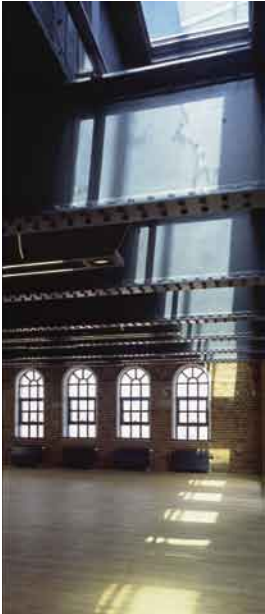
Vom Gymnastikraum aus sind die genieteten Stahlträger des alten Wassertanks gut zu erkennen. Darüber befindet sich der Pool.
