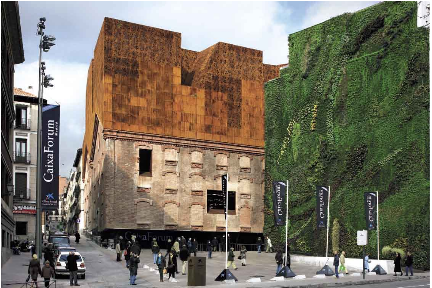
Mehr Raum für Kunst und Kultur: vor dem Caixa Forum ist ein kleiner Platz entstanden. Die angrenzende Brandmauer wurde für einen vertikalen Garten genutzt.
