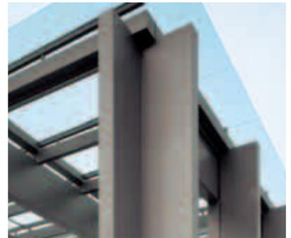
Die Primärkonstruktion setzt sich aus Stützen und Trägern zusammen. Für den architektonischen Ausdruck sind die Scharfkantigkeit und die glatten Oberflächen der raumbildenden Rahmen zentral.
