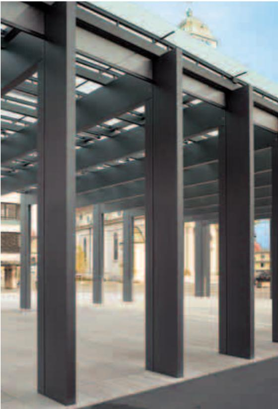
Diese dient dazu, Installationen wie Wasser und Elektrik unsichtbar zu führen. Da die Halle nur aus Rahmentragwerken besteht, wurde der Anschluss in den Rahmenecken biegesteif ausgeführt. Die Anschlüsse sind trotzdem kaum sichtbar. Um auch bei den geschraubten Verbindungen des Trägers an die Stützen die Flächenbündigkeit zu erreichen, verwendete man Senkkopfschrauben. Der Oberflächenschutz der Kastenkonstruktion besteht aus einer Feuerverzinkung mit organischer Beschichtung.
