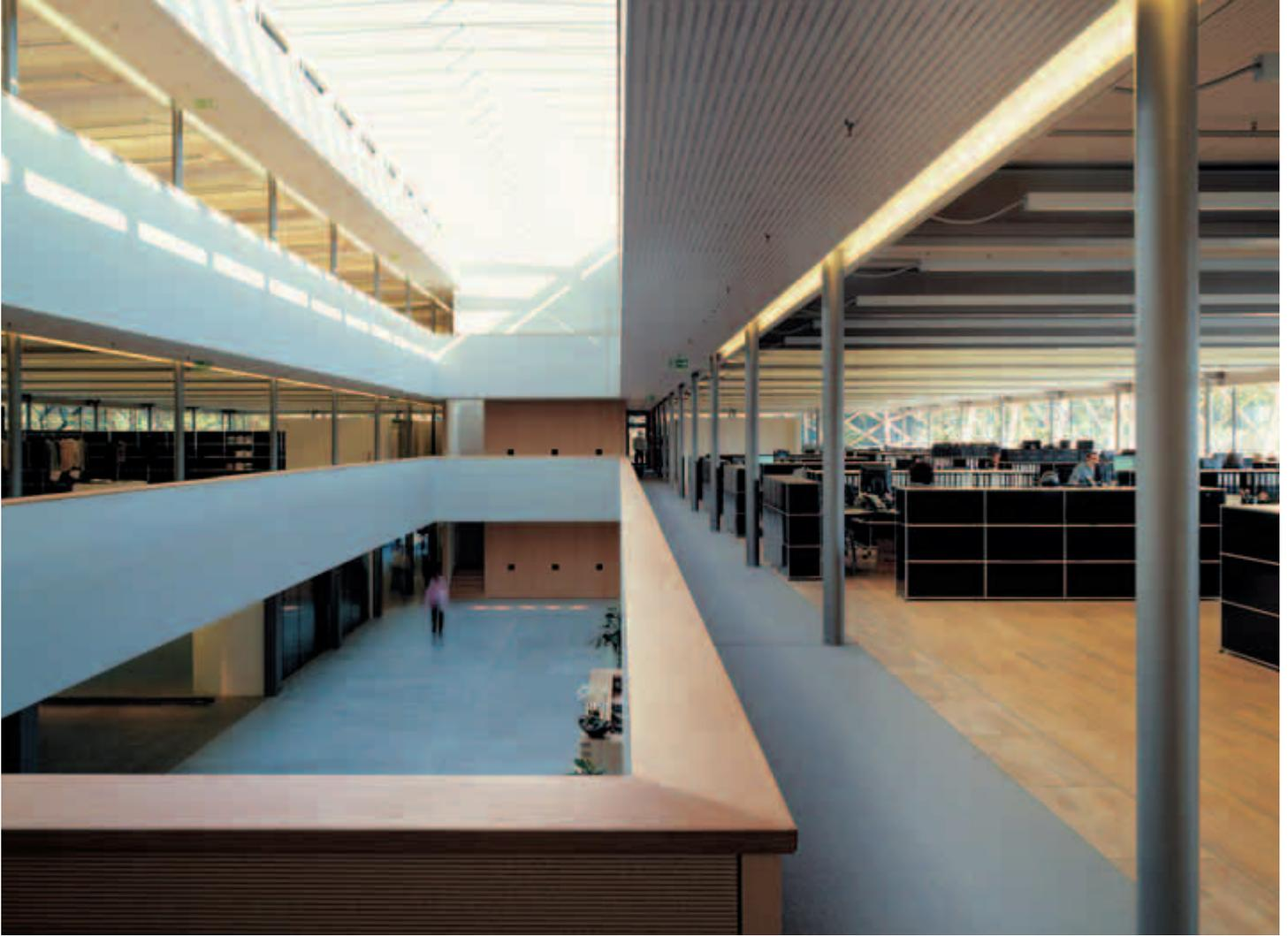
Une structure en acier composée de poteaux et de poutres d'une portée de 14 mètres permet un espace ouvert et une utilisation flexible. Les surfaces des locaux intérieurs sont en bois.
