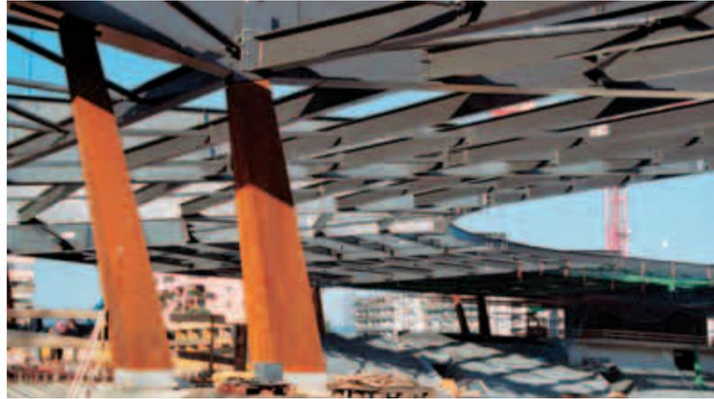
La hauteur des poutres est variable de 1,10 à 3,45 mètres, pour une longueur entre 29 et 43 mètres. L'épaisseur des tôles varie de 20 à 100 mm. Le poids de l'élément le plus lourd est de 52 tonnes.
