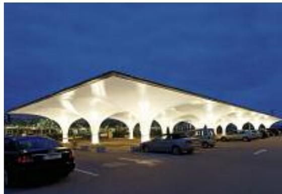
**La couverture du parking situé devant l'entrée principale de l'aéroport de Linz abrite 130 places de stationnement. Composée d'une structure métallique enveloppée de membranes en matière synthétique, l'ouvrage est conçu pour pouvoir être aisément démonté et remonté ailleurs en cas de réalisation d'un parking à plusieurs étages.**
