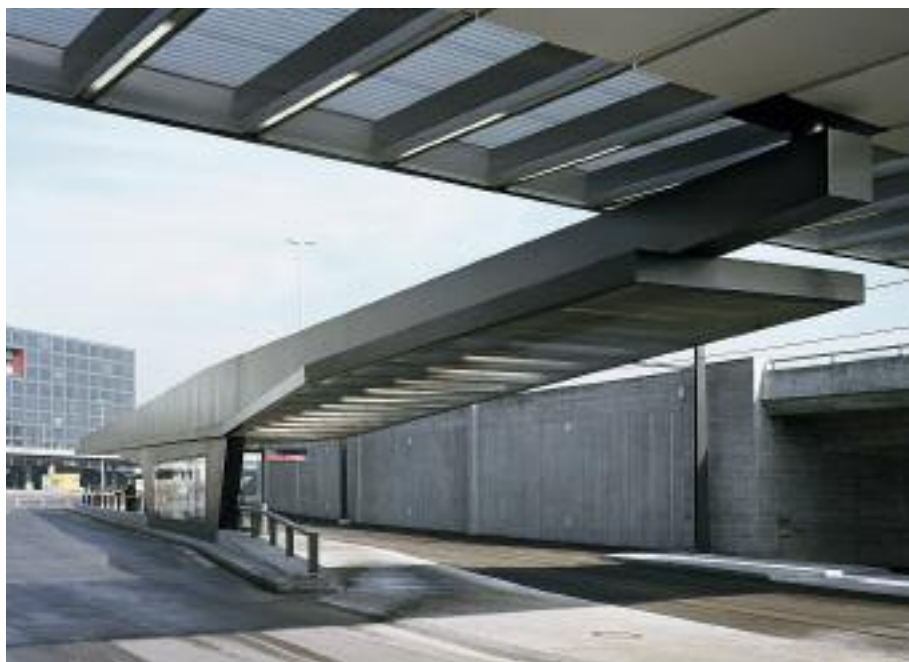
Les imposantes poutres-caissons en acier permettent de conférer aux toits en porte-à-faux une impression de légèreté.
