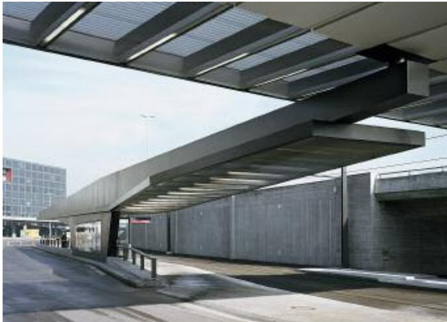
Dank der mächtigen Kastenträger aus Stahl strahlen die weit auskragenden Perrondächer eine scheinbare Leichtigkeit aus.
