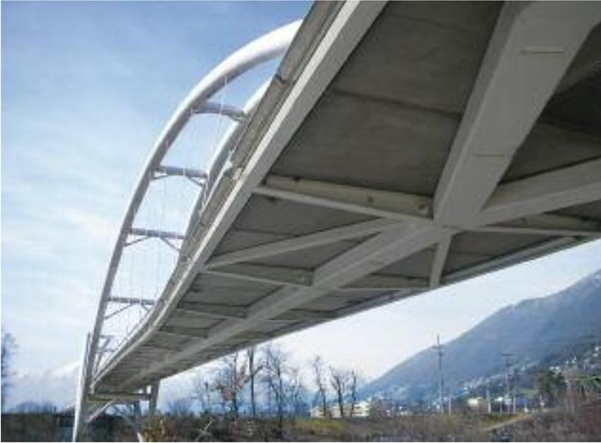
Le tablier se compose d'éléments en béton préfabriqués, reposant sur une structure métallique horizontale suspendue aux arcs par des haubans.
