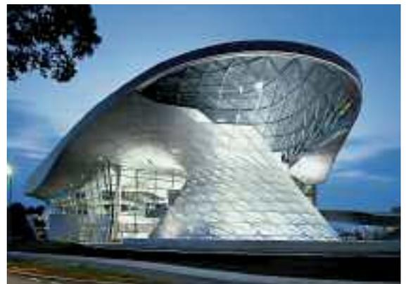
Aus einem Doppelkegel – einer geschweissten Dreiecksgitterstruktur aus Stahlhohlprofilen – entwickelt sich das etwa 16 000 Quadratmeter grosse Dach. Sein bis zu 15 Meter hohes Raumfachwerk aus Stahl, das allseits mit nichtrostenden Stahlpaneelen verkleidet ist, wird nur von wenigen Stützen und Auflagerpunkten getragen. Die auf- und abwogende Unterseite gliedert die Halle, definiert die einzelnen Funktionsbereiche und verleiht dem Gebäude seinen innovativen und dynamischen Charakter.
