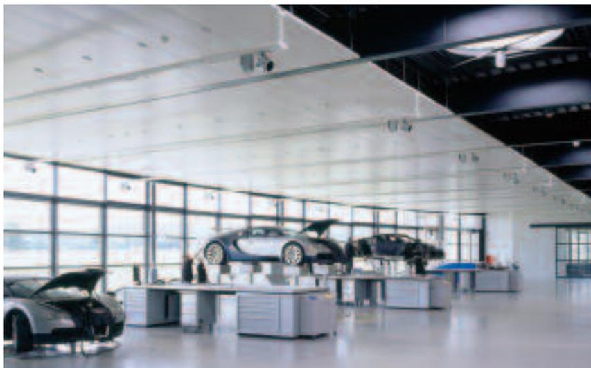
L'ovale est une construction en acier, enveloppée d'une tôle perforée. Sur la façade étroite, des panneaux de couleur aluminium règlent l'entrée de la lumière. Le vitrage s'étend depuis le sol jusqu'au toit à 6,5 m de hauteur.
