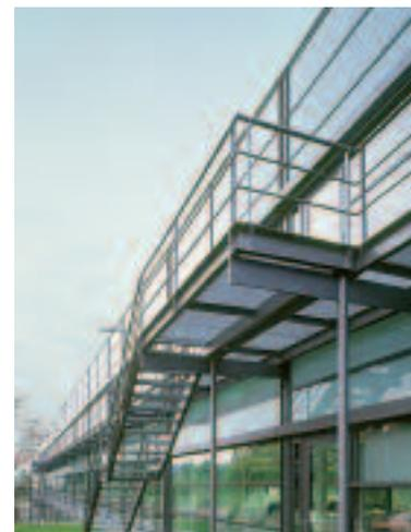
Die Fassade besteht aus gewalzten Stahlprofilen. Die offenen Profile verleihen der Fassade Filigranität und Eleganz.
