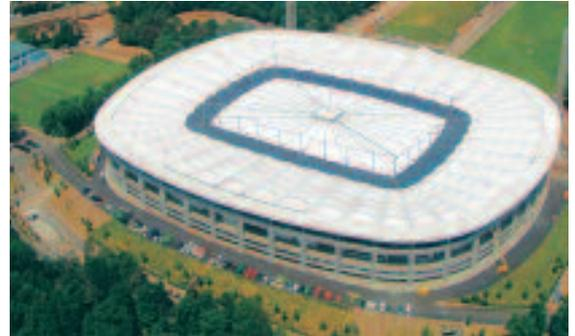
**Wie ein feines Spinnennetz spannt sich die Dachhaut des Frankfurter Stadions über die Arena. Das Stahlseil-Membrandach mit einer Spannweite von 240 Metern gewährleistet trotz vollständiger Überdachung das natürliche Wachstum des Rasens. Statisch gleicht der Dachaufbau einem Speichenrad.**
