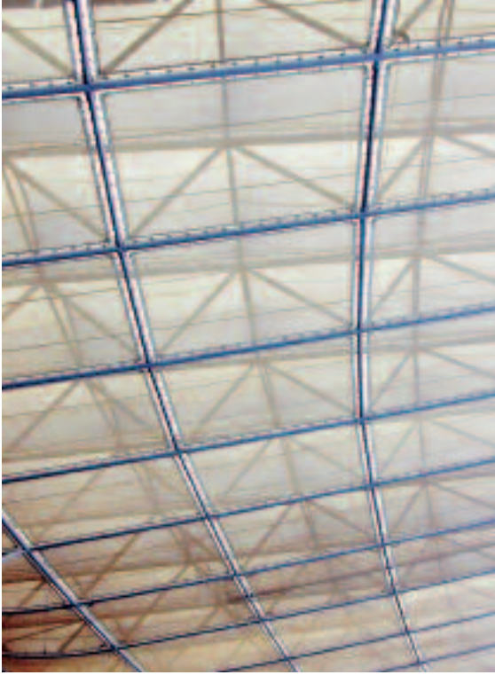
A travers le tissu translucide en fibre de verre revêtu d'une couche de PTFE, on entrevoit en filigrane le treillis à tubes d'acier.
