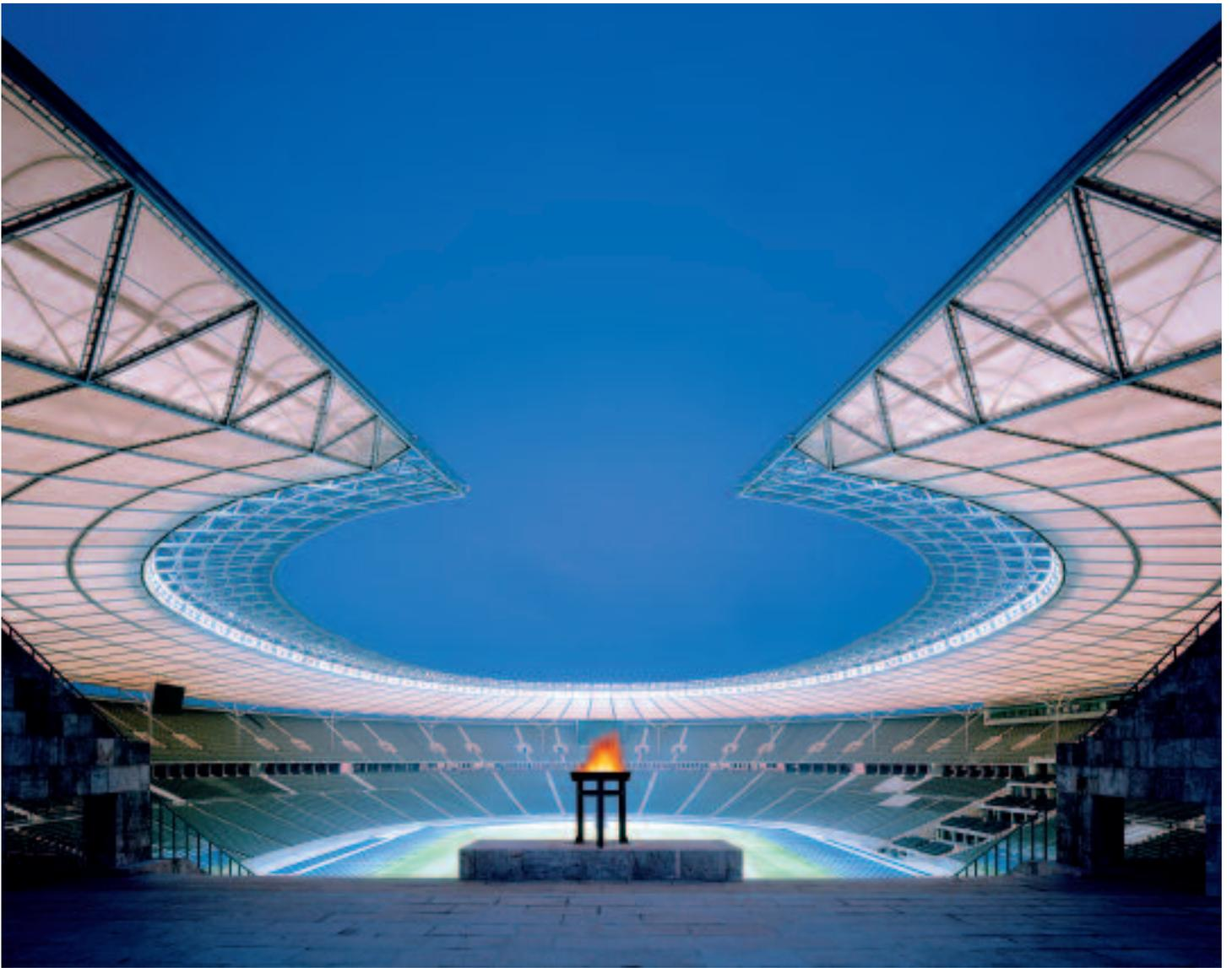
Das leichte Dachtragwerk überflügelt das Stadiondenkmal. Die 20 Baumstützen und eine umlaufende Stützenreihe am Dachrand sind die einzigen Berührungspunkte zwischen Alt und Neu.
