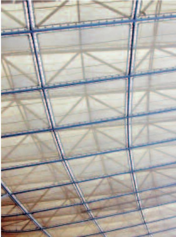
Durch das transluzente PTFE-beschichtete Glasfasergewebe bleibt die filigrane Stahlrohrfächerkonstruktion erkennbar.
