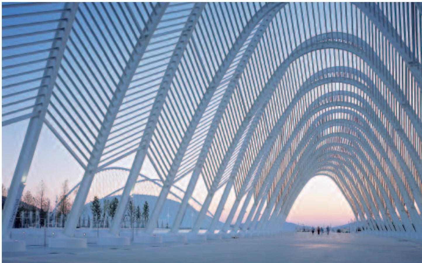
Grâce à un jeu habile des forces, 17 000 tonnes d'acier s'élèvent en apesanteur. Les deux arcs tubulaires impressionnants, de 304 m de portée et de 72 m de hauteur, sont visibles de loin et dotent la ville d'Athènes d'un fort symbole.
