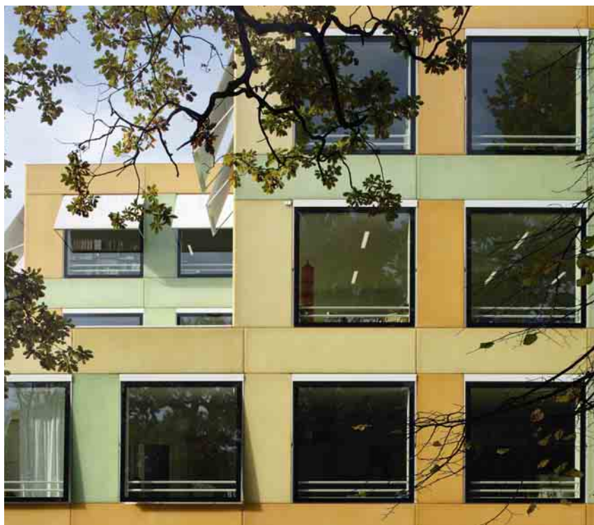
Das prägnante Raster der Stahlrahmen gliedert die Fassade. Glasfaserverstärkte Kunststoffpaneele in verschiedenen Farbtönen differenzieren das Fassadenbild.
