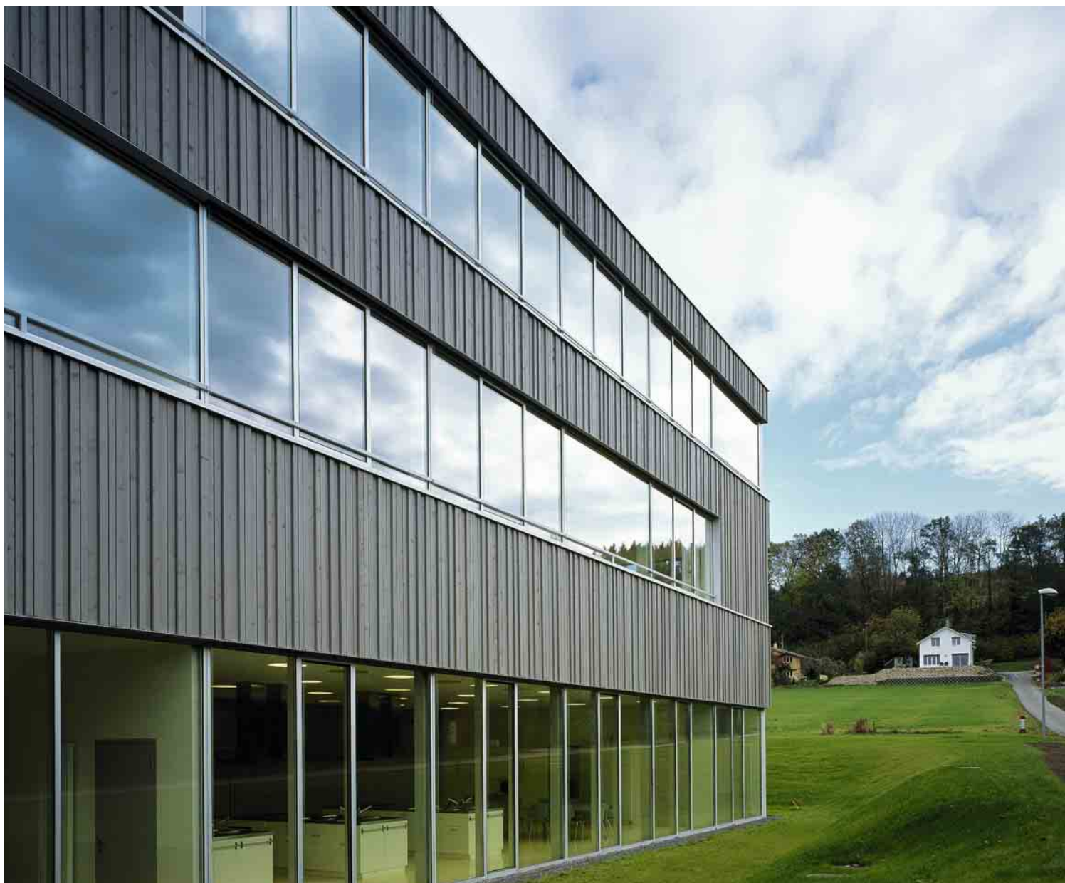
Horizontale Fensterbänder und feine Aluminiumleisten gliedern den Baukörper. Die unbehandelte Holzfassade aus Fichte wurde vorbewittert und wird mit der Zeit mehr graue Patina annehmen.
