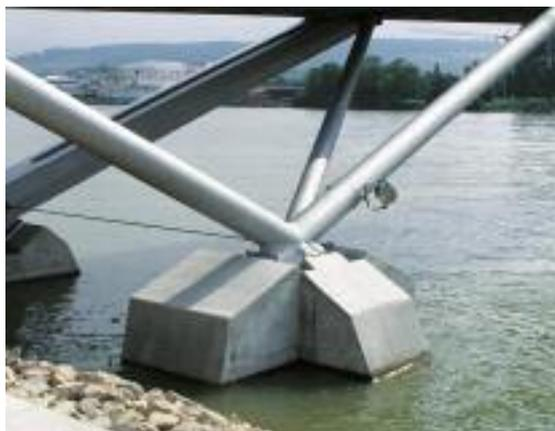
Der asymmetrische Brückenquerschnitt und temperaturbedingte Längenänderungen führten zu der unterschiedlichen Ausbildung der Bogenfußpunkte: verschiebbliche Konstruktion in Weil am Rhein und Festpunktausbildung mit Kalottenlagern in Huningue.
