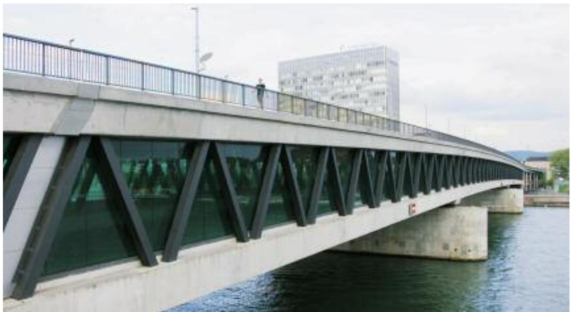
Le vitrage du niveau inférieur, tout le long du côté sud et dans les zones extrêmes du côté nord, réduit les nuisances sonores générées par le trafic de transit.
