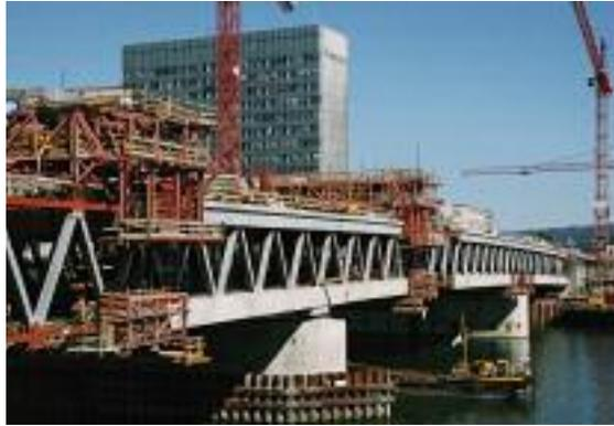
Le tablier est bétonné par étapes hebdomadaires de 7 mètres, progressant de façon symétrique et en partant des piles, à l'aide des plateformes se déplaçant sur les membrures supérieures.
