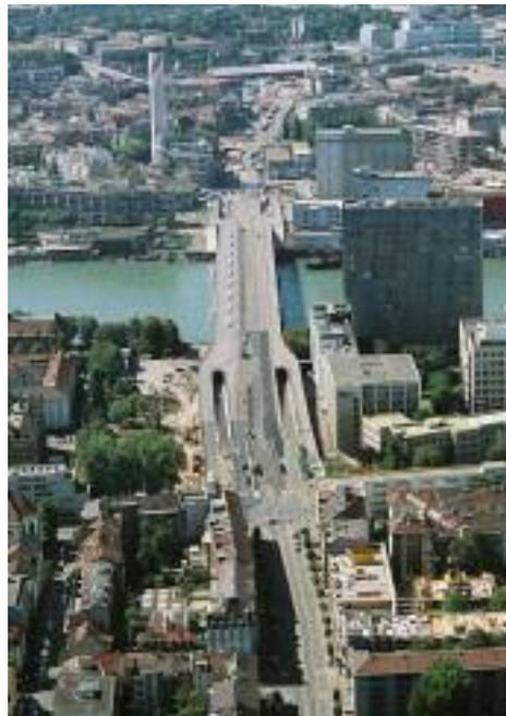
**La structure à treillis finement articulée en construction mixte acier béton du pont Dreirosen révèle facilement sa fonction double: trafic local en haut, trafic de transit en bas. Par ce concept à deux niveaux, les architectes ont intégré de façon harmonieuse l'axe de trafic dans le tissu urbain et ont créé en même temps un «boulevard» pour les piétons et de l'espace pour des activités variées de la ville.**
