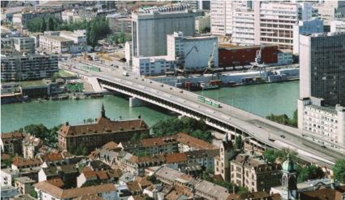
Die doppelstöckige Zwillingsbrücke ist das markanteste Bauwerk der Nordtangente Basel.
