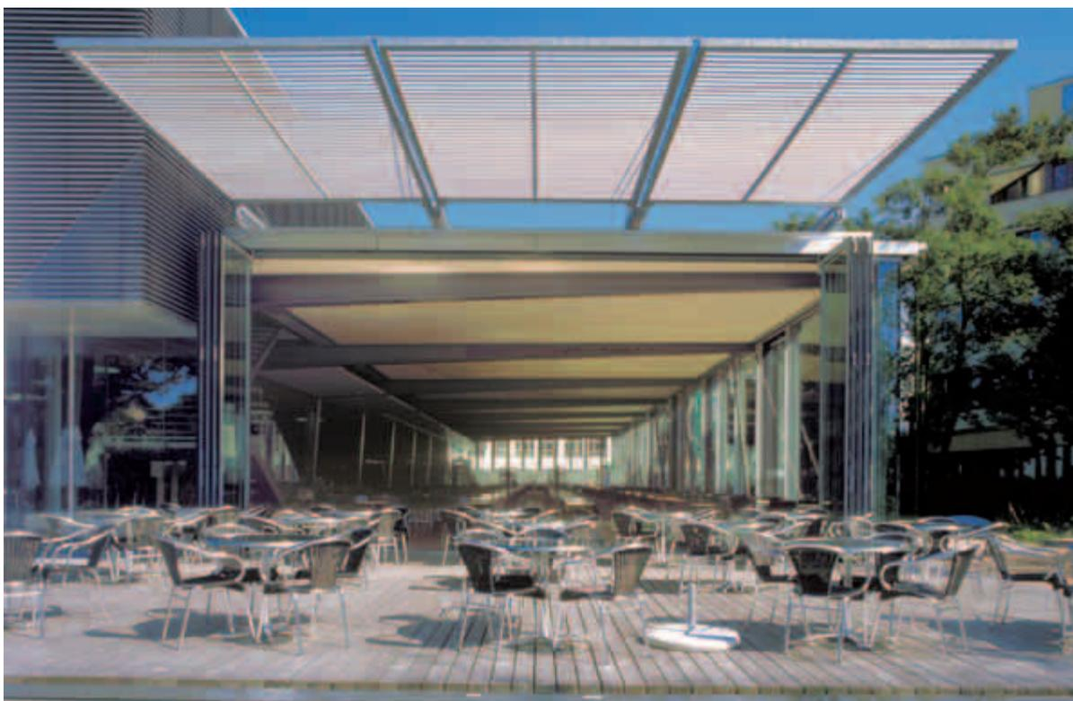
Die Glaswände können an den Schmalseiten vollständig geöffnet werden, so dass der Innenraum mit den Terrassen direkt verbunden ist.
