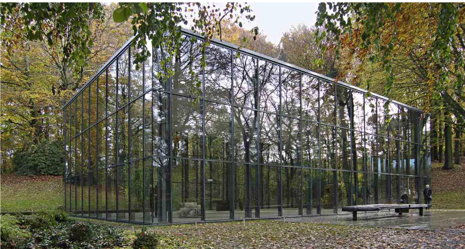
section en croix qui abritent les descentes et autres conduites. Dans le pavillon en verre, fermé de toute part, des fentes placées aux bords du sol en béton gris permettent l'entrée de l'air, dont les clapets d'aération aménagés dans le toit permettent l'évacuation. En hiver, le chauffage au sol garantit une température agréable.
