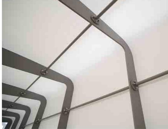
L'espace intérieur polyvalent est fermé aux extrémités par des panneaux en verre. Une membrane translucide, tendue sur les cadres en acier, forme le toit et les parois latérales.
