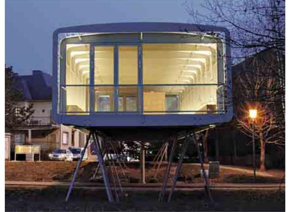
La durée limitée du chantier et le caractère démontable de la construction ont déterminé le choix des matériaux. La structure préfabriquée en acier a été assemblée sur place par boulons. La rigidité dans le sens longitudinal est assurée par des tubes ronds placés entre les cadres et par deux longerons en acier sous ces derniers. Les forces horizontales sont reprises par des béquilles très élancées.
