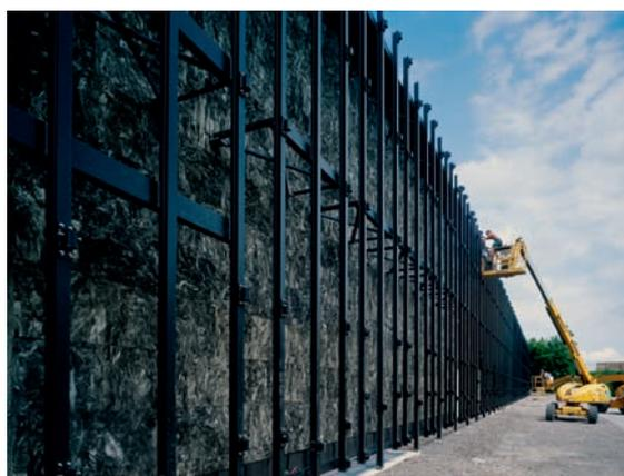
Montage de la façade du bâtiment numéro 1: les plaques d'acier sont disposées à une distance de 1,30 m devant l'isolation thermique noire du mur. Pour l'infrastructure (HEA 100) et les fixations, afin de prévenir la corrosion, on a veillé à faciliter l'écoulement de l'eau.
