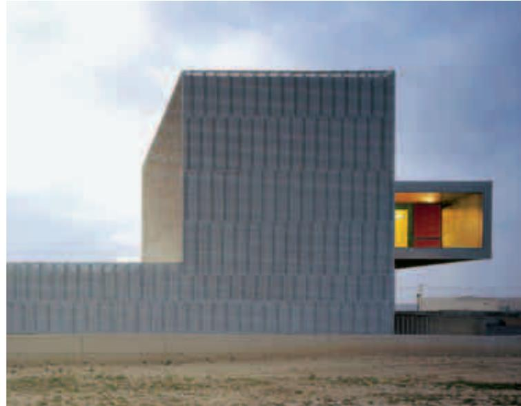
La façade est complètement enveloppée dans un filet aux mailles fines à l'apparence homogène d'un textile.
