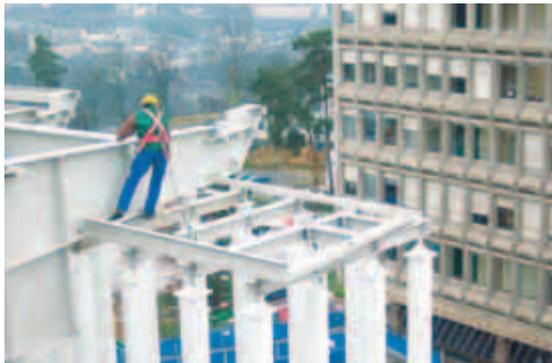
Montage de la structure en acier. 74 poutres en treillis de longueur variée rayonnent depuis un noyau en béton. Côté façades, elles reposent sur des poteaux en tube d'acier par l'intermédiaire d'une structure d'appui.
