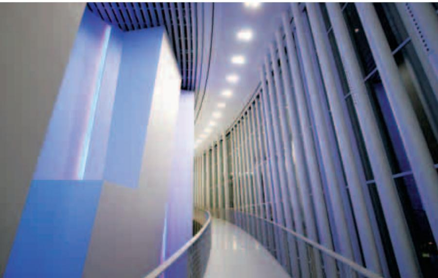
Die Säulen, welche die Fassade stabilisieren, sind untereinander durch ein filigranes Vierkantprofil verschweisst. Hingegen die inneren Säulen erfüllen keine statische Funktion, dienen jedoch der Integration der Lüftungsanlage und haben ansonsten die gleichen materiellen Eigenschaften wie die äusseren Säulen. Der Säulenwald bricht das seitlich einfallende Licht, so dass das Foyer, welches sich leicht ansteigend um den Konzertsaal wickelt, wie im musikalischen Rhythmus erhellt wird.
