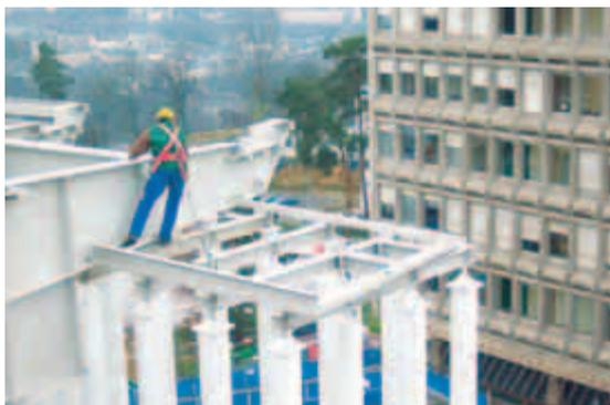
Montage der Stahlkonstruktion. An einem Betonkern schliessen strahlenförmig 74 Stahl-Fachwerkbinder unterschiedlicher Länge an. Die Fachwerkbinder werden fassadenseitig durch eine Stützkonstruktion auf Stahlrohrstützen aufgelagert.
