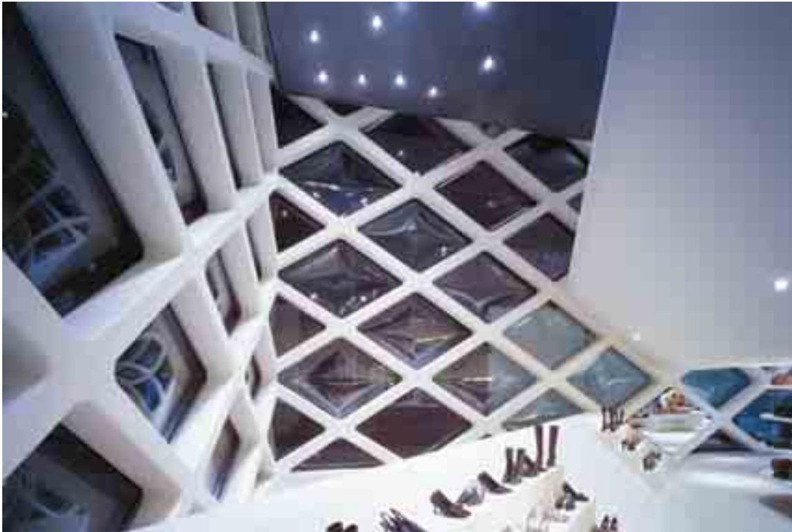
Decken, die nicht bis zur Fassade reichen, generieren überhohe Räume. Im Erdgeschoss bildet eine schräge Brüstung den Abschluss.
