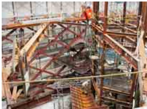
Dank der aussteifenden Wirkung der Fassade konnten die Stahlstrukturen in den Kernen ohne Windverbände ausgeführt werden.
