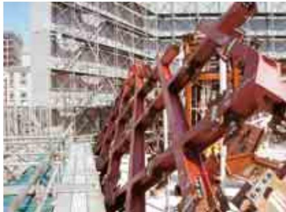
Bei grossem Lastanfall wurden an den Gebäudekanten Gussteile eingesetzt.
