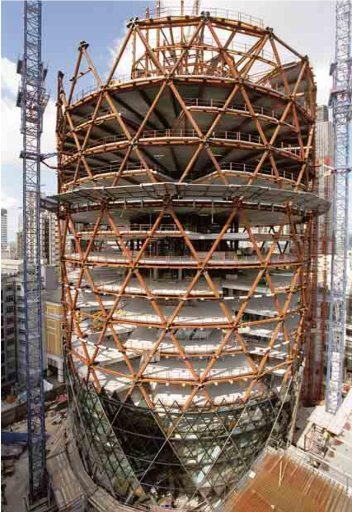
Während in den oberen Geschossen die Montage des Stahlbaus noch voll im Gange war, wurde unten bereits die Fassade angebracht.
