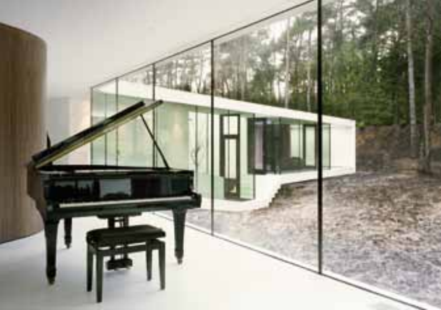
Der Blick aus dem Studierzimmer wird durch keine Stütze getrübt.
