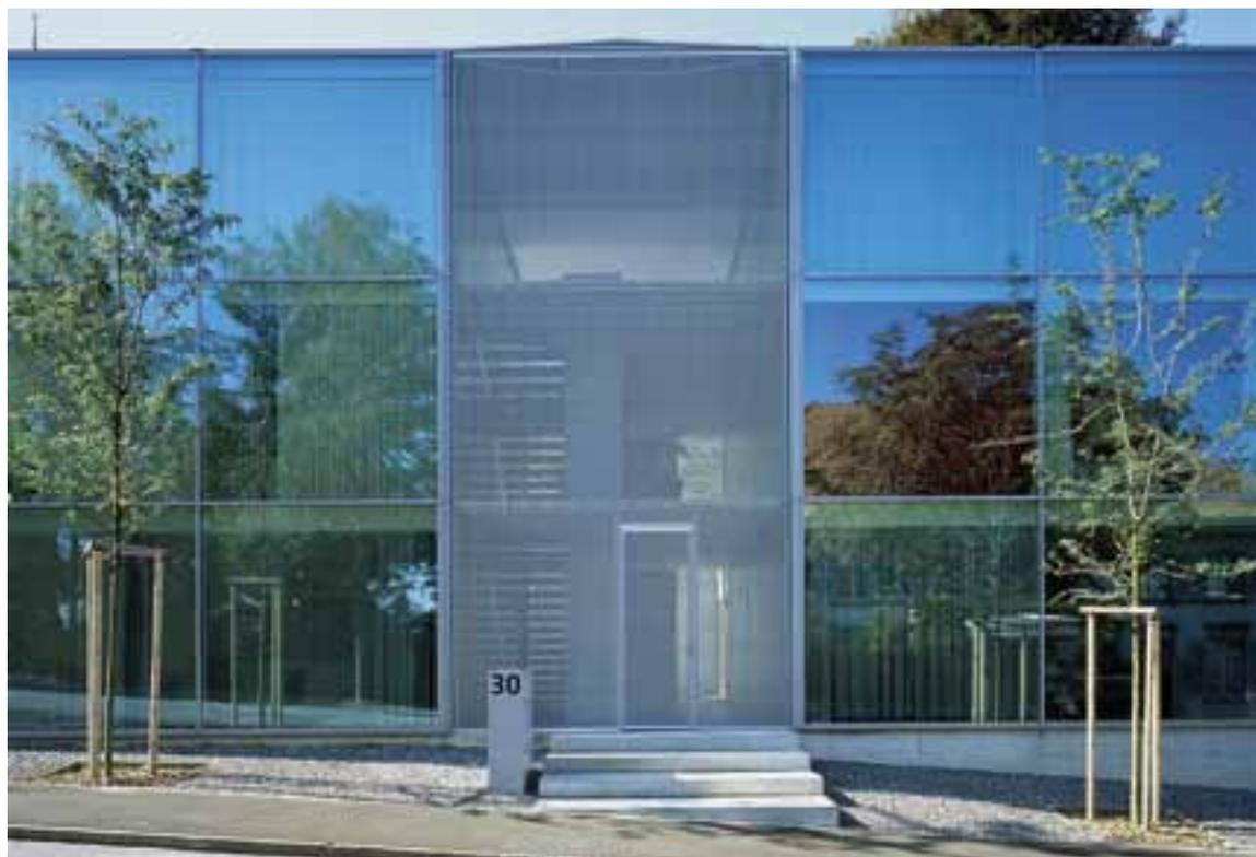
Das offene Treppenhaus ist nur mit einem feinmaschigen Metallgitter abgeschlossen.
