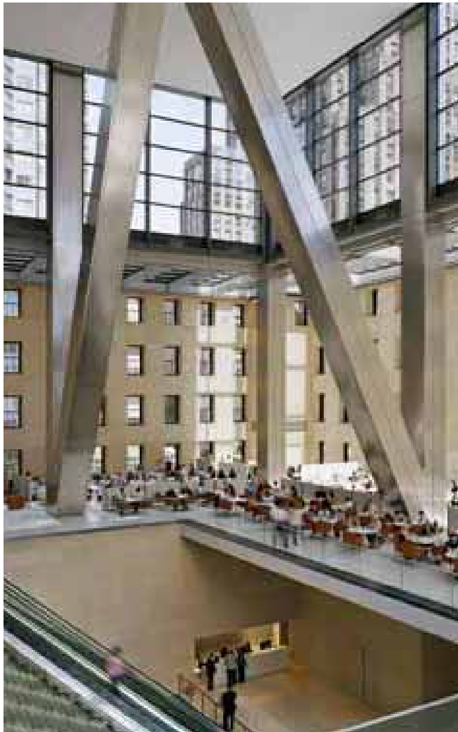
Senkrecht und schräg durch das etwa 29 Meter hohe Foyer verlaufende, mit Edelstahl verkleidete «Mega»-Stützen tragen die Lasten des Büroturms ab.
