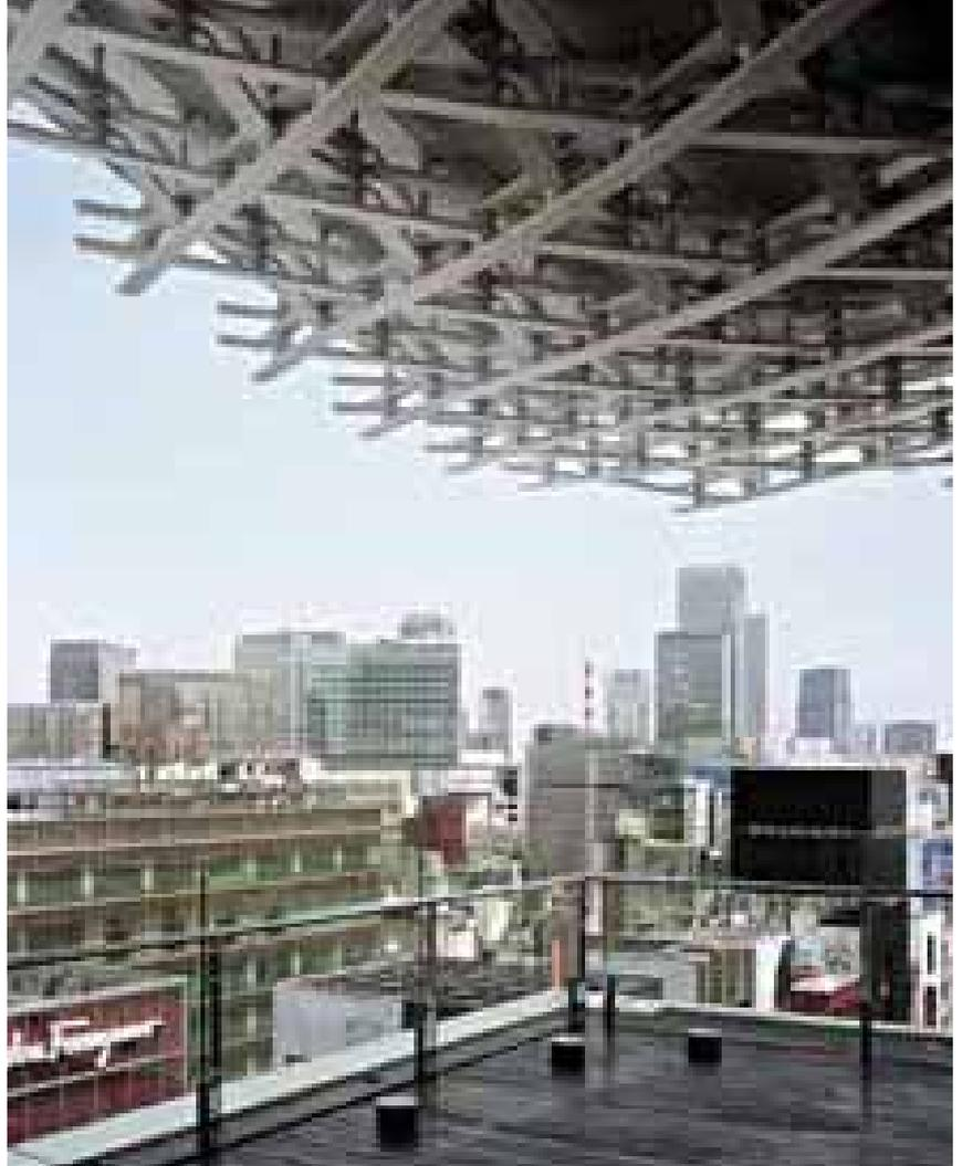
Ein derart ausgefallenes Gebäudekonzept verlangt nach einem entsprechenden Abschluss: Das geschwungene Dach ist aus Flachstählen gefertigt, die sich in mehreren Schichten überlagern.
