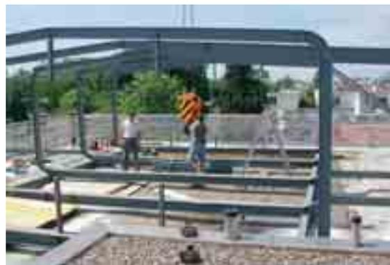
Die Stahlkonstruktion besteht hauptsächlich aus IPE-Profilen, die zu Rahmen geschweisst wurden. Eine leichtere Konstruktion ist kaum möglich.
