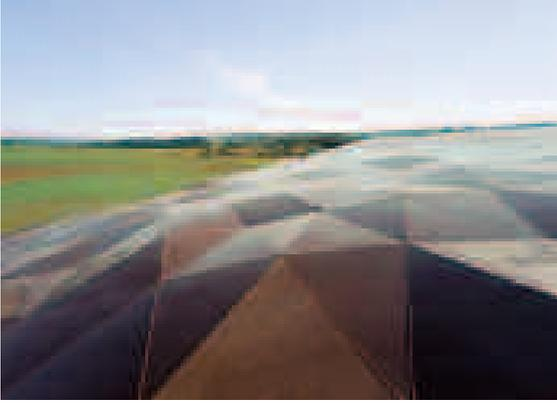
Die Segmente werden auf der Baustelle montiert. Damit die Oberfläche gleichmässig oxidiert, wurde diese Arbeit des Sandstrahlens und Oxydierens vor Ort erledigt.
