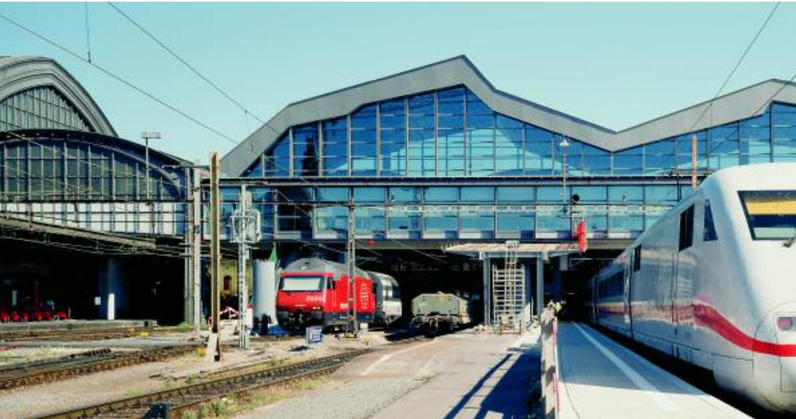
Die Haupttragelemente in Längsrichtung sind aus zusammenschweißten Kastenträgern gebildet, welche von einer minimalen Höhe von 60 Zentimetern bis auf 2,60 Meter anwachsen.
