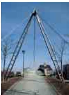
Das räumlich verspannte Seiltragsystem ist an A-förmigen Gitterpylonböcken aufgehängt.
